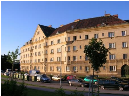
Ältester Wohnbau des Roten Wien: Matzleinstaler Hof
